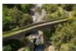
P69 Pont de Rejus Pont-de-Labeaume
