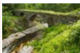
P66 Pont de Malfaugère Montpezat-sous-Bauzon
