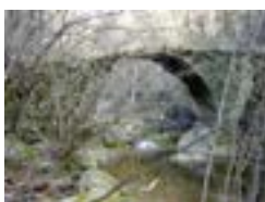
P48 Pont-Rieuclard Jaujac
