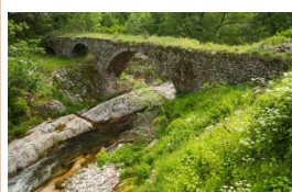
P66 Pont de Malfaugère Montpezat-sous-Bauzon
