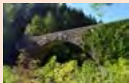
P1 Pont du Sigadou Barnas
