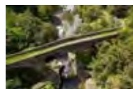
P69 Pont de Rejus Pont-de-Labeaume
